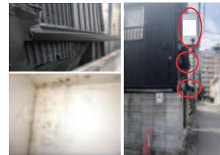
外壁の損傷 躯体漏水によるカビ
